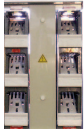
Abb. 8: Sammelschienenabdeckung
