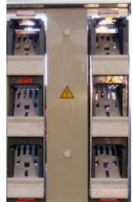
Abb. 8: Sammelschienenabdeckung
