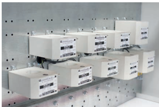
Montaggio del trasformatore di corrente
