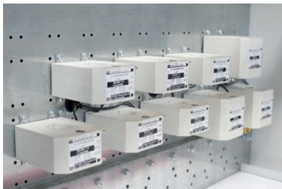
Installation des transformateurs de courant
