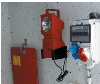
Bild 18: LED-Handnotleuchte in Wandhalterung und Halterung für Isolierende Schutzplatte
