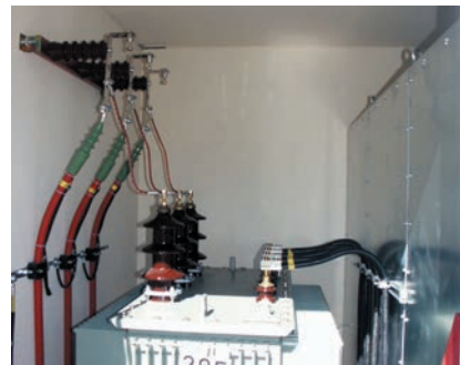
Bild 20: Mittelspannungs-Kabelanschluss traverse
