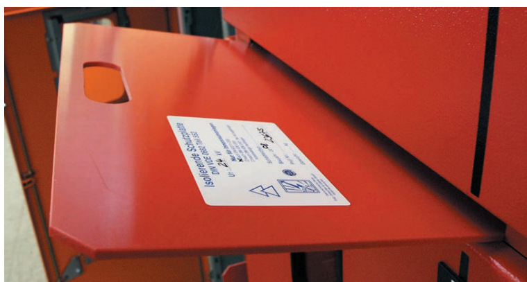
Bild 14: Einbringen einer Isolierenden Schutzplatte
