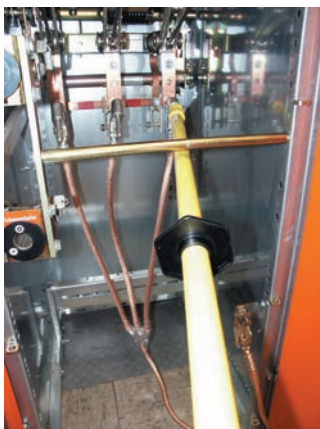
Bild 2: Erdungstange beim Anbringen einer Erdungsgarnitur
