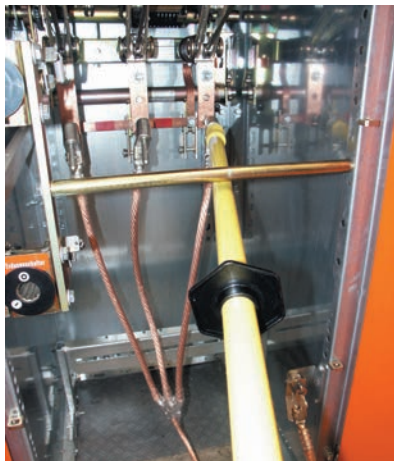
Bild 12: Anbringen einer Erdungs- und Kurzschliessgarnitur mit einer Erdungsstange
