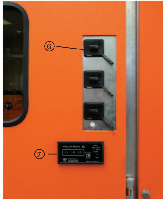
**Bild: Kapazitive Schnittstelle und Kurzschlussanzeiger**
