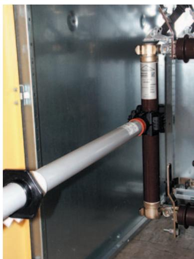
Bild 6: Sicherungszange gerade
