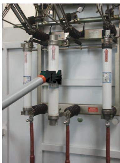
Bild 7: Sicherungszange abgewinkelt
