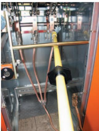
Bild 2: Erdungstange beim Anbringen einer Erdungsgarnitur
