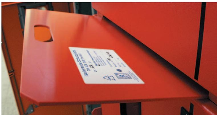
Bild 14: Einbringen einer Isolierenden Schutzplatte
