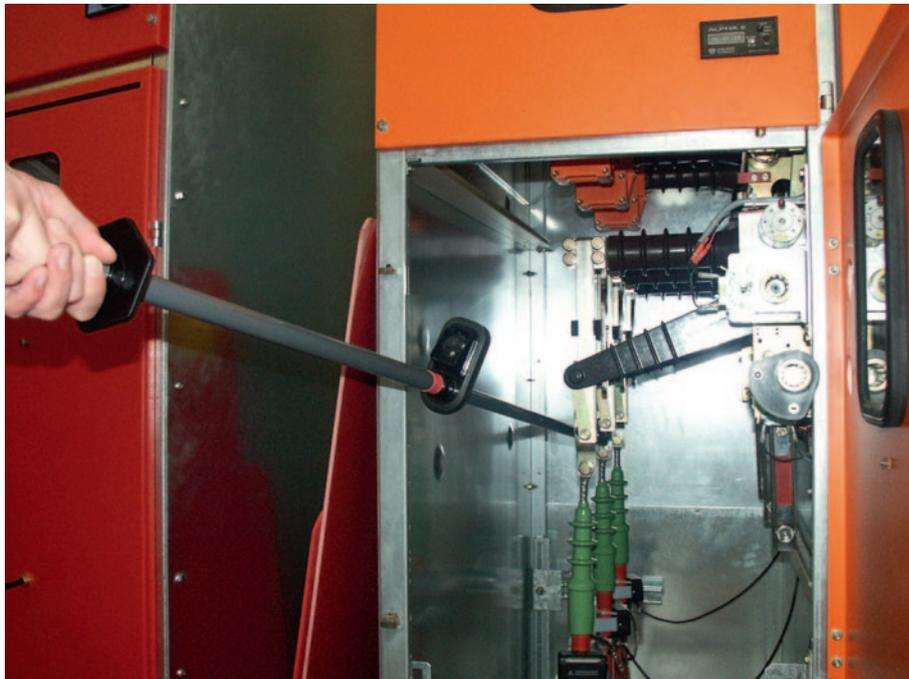
Bild 8: Passiver Spannungsprüfer mit optischer LED-Anzeige
