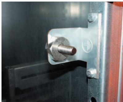
Bild 9: Erdanschlussbolzen
