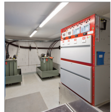
Abb.: oben Darstellung ECOS-Z in begehbaren Station, unten nichtbegehbare Station
