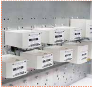
Stromwandlereinbau
